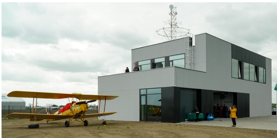
Rys. 1.1: Zdjęcie budynku z masztem umieszczonym na dachu jednej z czterech stacji radaru pasywnego w Przasnyszu [15]
